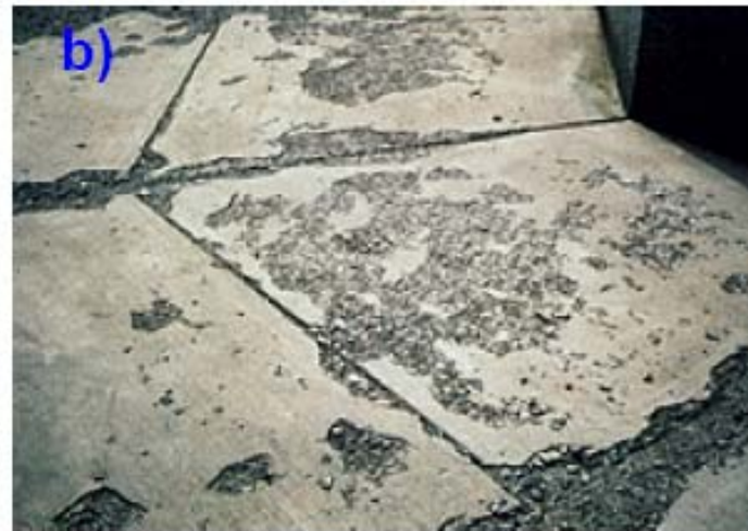
Spalling
