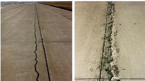
Edge Cracking (L,H)
