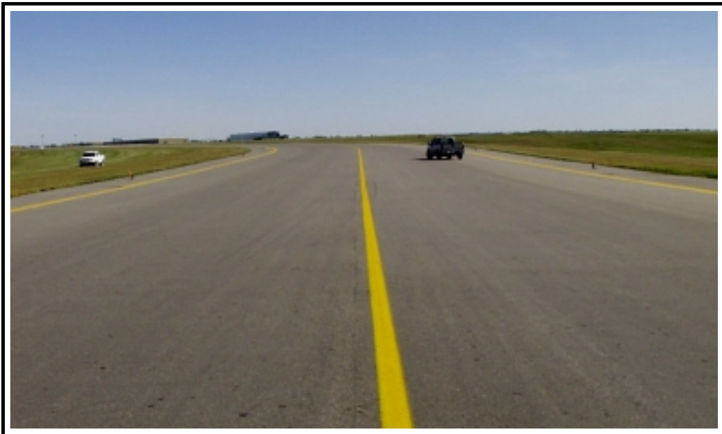
Photo 12 : État général de la section de contrôle - Septembre 2000
