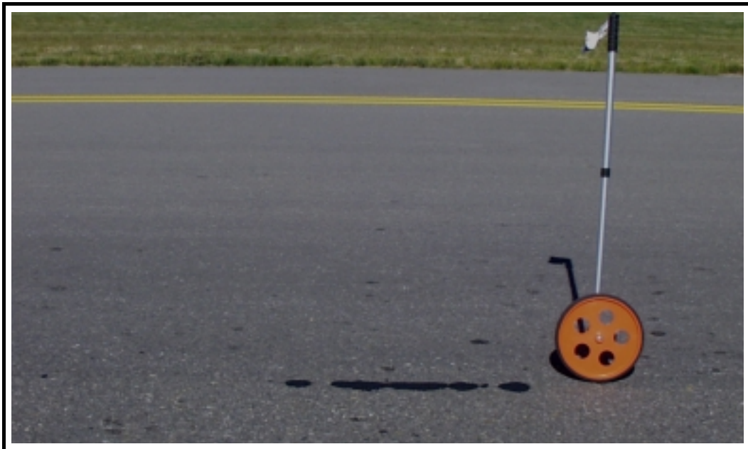
Photo 8 : Ressuage mineur le long d'un joint longitudinal dans la section d'essai de liant classé selon le rendement- Septembre 2000
